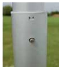
Encaje de seguridad de los elementos telescópicos
